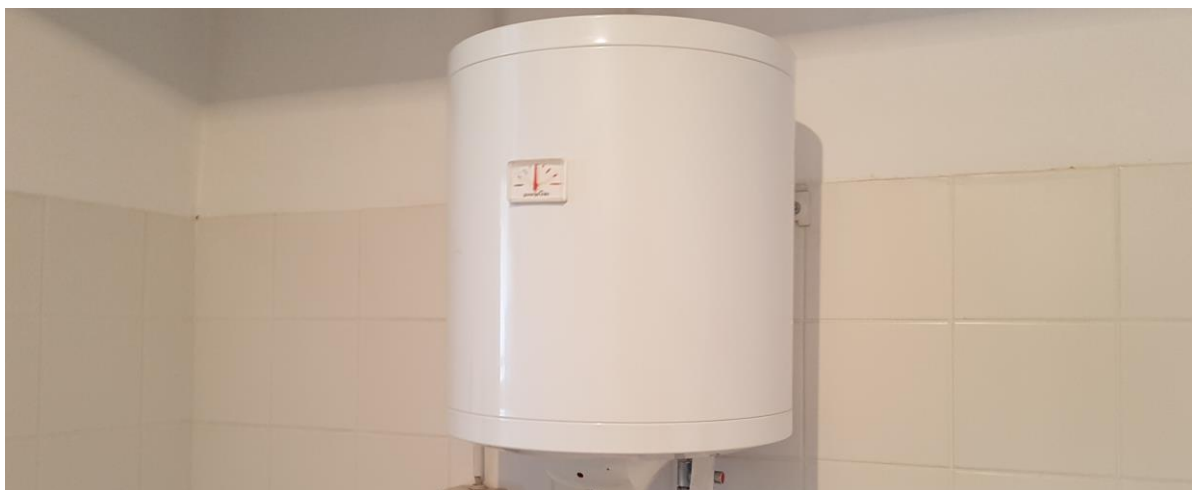
Slika 5: Bojler tople sanitarne vode
